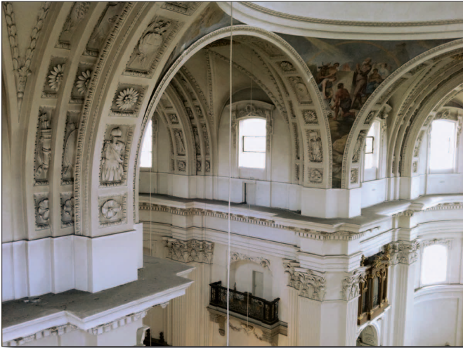
Blick vom Gerüst in die Kuppelzone der Kathedrale von Solothurn, die am 3. Januar 2011 Opfer eines Brandanschlages wurde.
